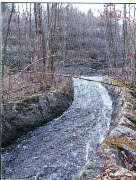
Figur 2.6. Nedersta delen av flötningsrännan vid utloppet i kraftstationens utloppskanal (källa: Spade, 2015).
