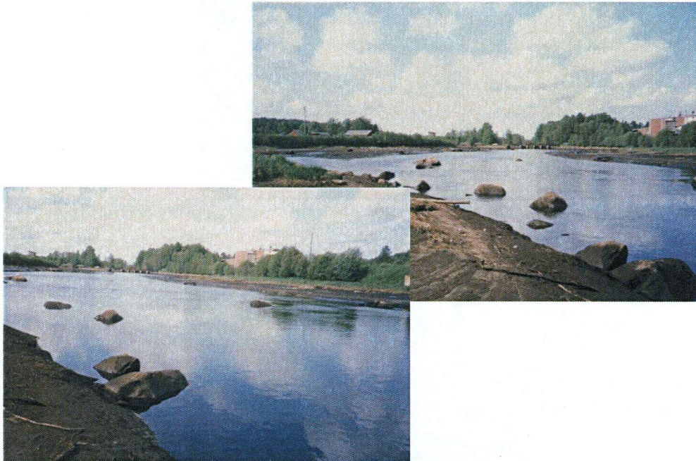
Figur 2.3. Fotografier från provtappning vid Sågverksdammen 1986. Ca 1 m avsänkning jämfört med dagens normalvattenyta. Fotografierna är tagna mot nedströmshållet. Sågverksdammen skymtar i bakkant av fotografierna.
